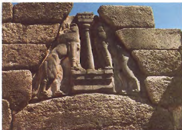
▲ Obr. 89 Hlavní vchod do Mykén představuje nepříliš vysoká (s ohledem na mohutné kvádry) Lvi brána. Její základní konstrukci tvoří dva velké kameny překlenuté třetím. Nad bránou je umístěn reliéf dvou lvcí stojících po stranách oltáře, jejichž hlavy vytesané ze samostatných kvádrů se nedochovaly. Sloup spočívající na oltáři je podobný sloupům paláce v Knosu. Tento reliéf je nejstarším příkladem monumentální plastiky v Evropě
