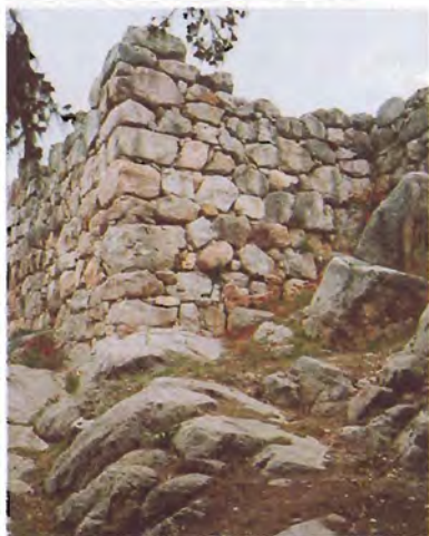
◀ Obr. 87 Podle pověstí vybudovali hrad Tiryns pro krále Proita maloasijské obří – kyklopy. Proto se mohutnému zdivu mykénských hradů říká kyklopské
