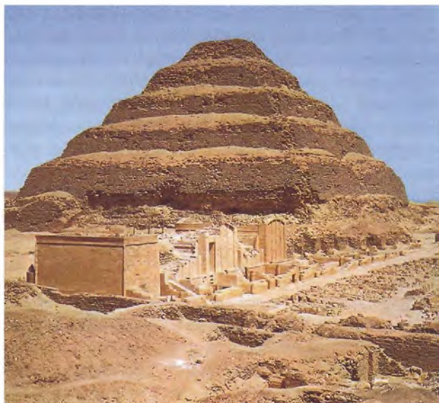
▲ Obr. 67 Stupňovitá pyramida faraona Džosera v Sakkáře je nejstarší egyptskou pyramidou. Její podoba je výsledkem několikrát změny stavebního plánu. Původní mastaba byla totiž vícekrát zvyšována a zvětšována. Stavitelem této pyramidy byl faraonův vezír Imhotep
