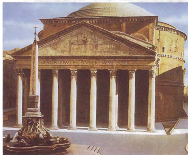
▲ Obr. 157 Panteon, chrám všech bohů, byl postaven na Martově poli Augustovým zetěm Markem Vipsaniem Agrippou. Počátkem 7. století se Panteon stal křesťanským chrámem Panny Marie a mučedníků, přesto zůstal interiér v původní podobě. Bronzový reliéf z trojúhelníkového tympanonu byl však sňat v 17. století
