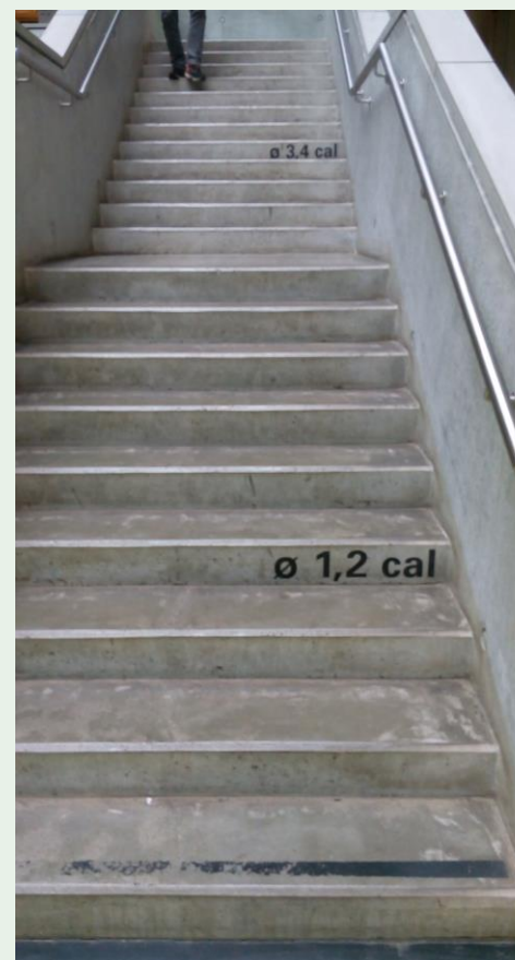
Schodiště TK v Dejvicích
