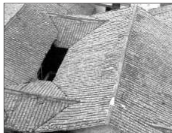
Pohled z ptačí perspektivy na typický jihočínský dům s „nebeskou studnou“. (KNAPP, s. 46)
