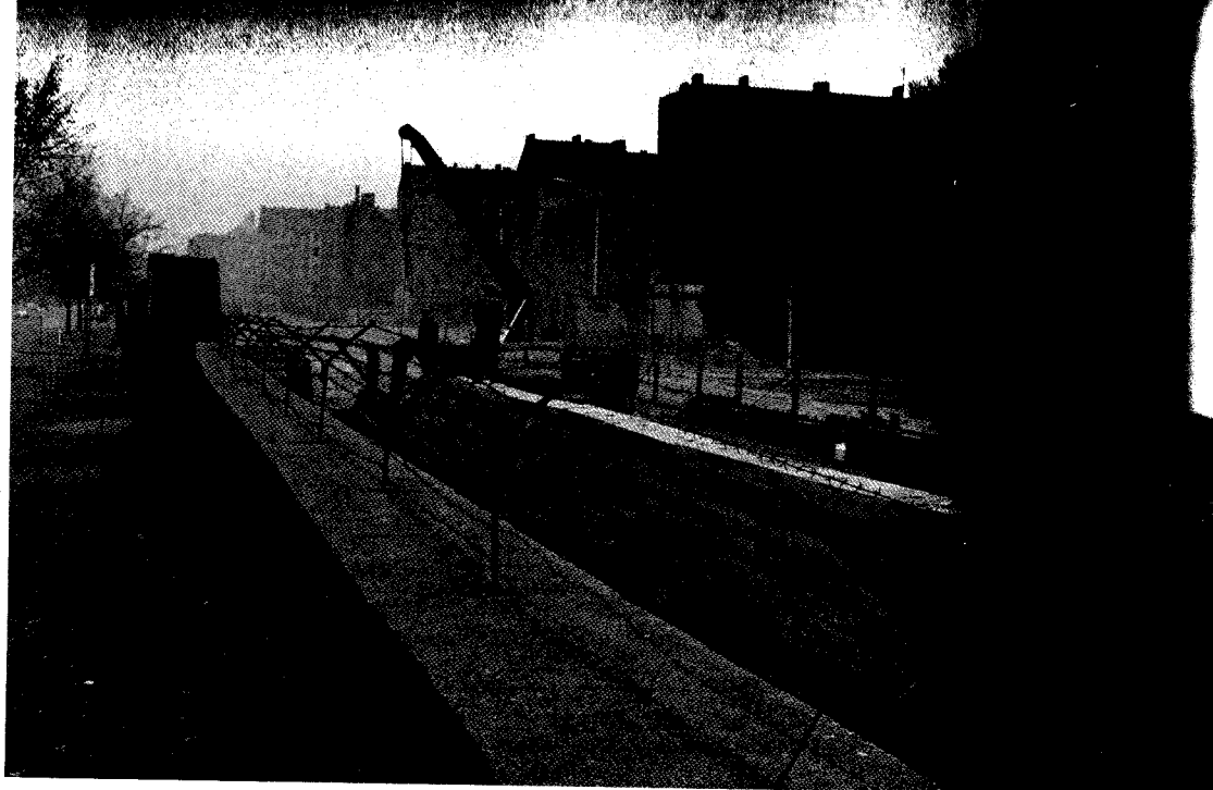
Stavba hraniční zdi ve Východním Berlíně, duben 1967
