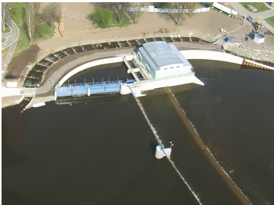
Dobře odborníky hodnocený rybí přechod u MVE na jezu Beroun. Zdroj Cech malých vodních elektráren.
