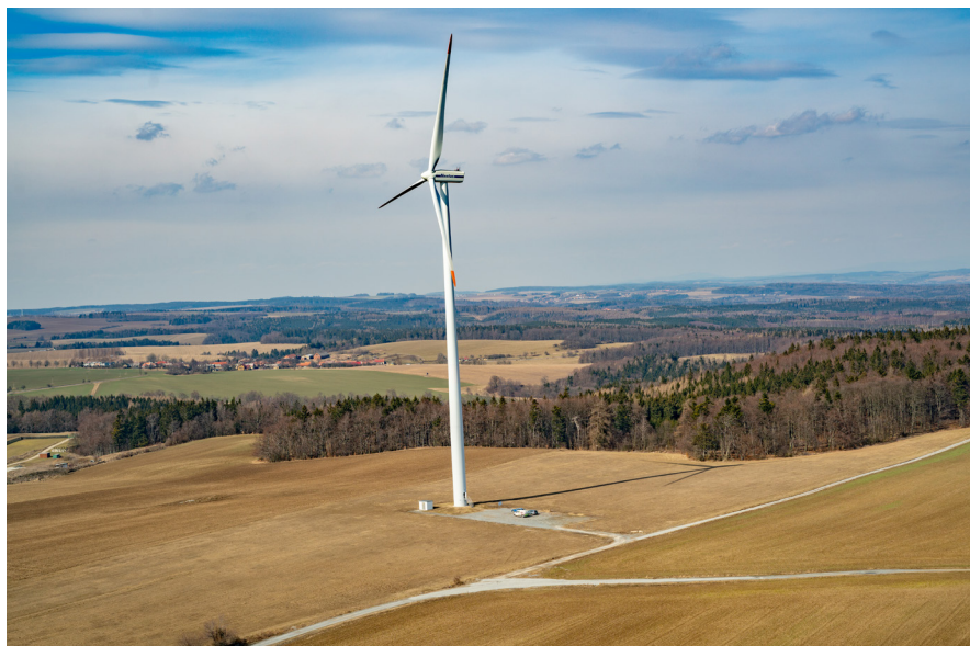
Podobně jako továrny, síla, komíny a jiné stavby ovlivňují větrné turbíny krajinný ráz vždy. Zdroj Česká společnost pro větrnou energii
