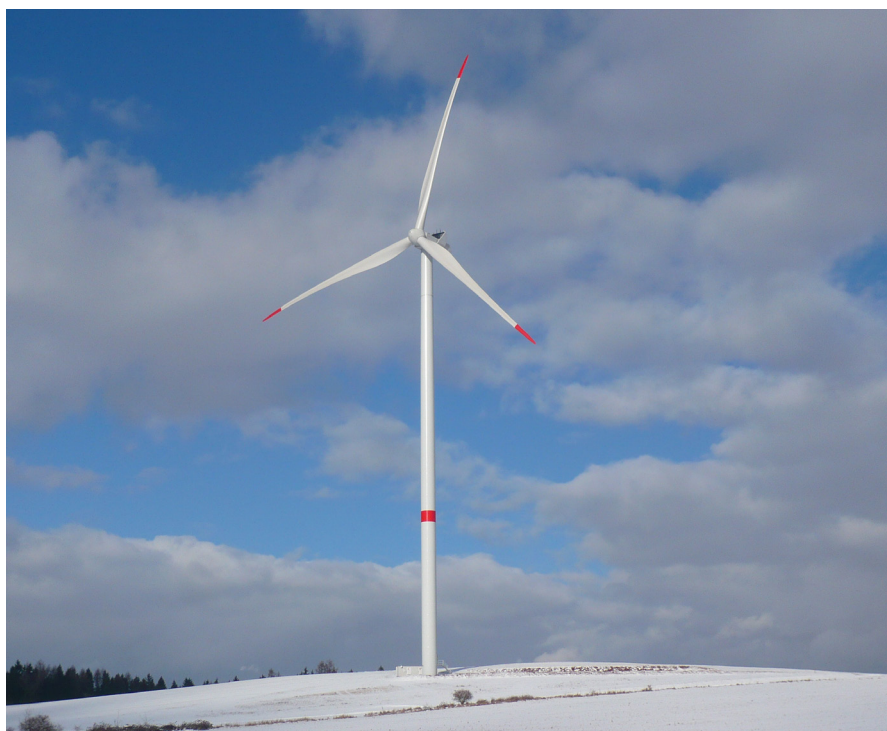
Větrné elektrárny pokrývají 16 % spotřeby elektřiny v EU. V Česku ale pouze 1%. Přitom větrný potenciál máme podobně dobrý jako sousední Rakousko nebo jižní Německo. Zdroj Česká společnost pro větrnou energii
