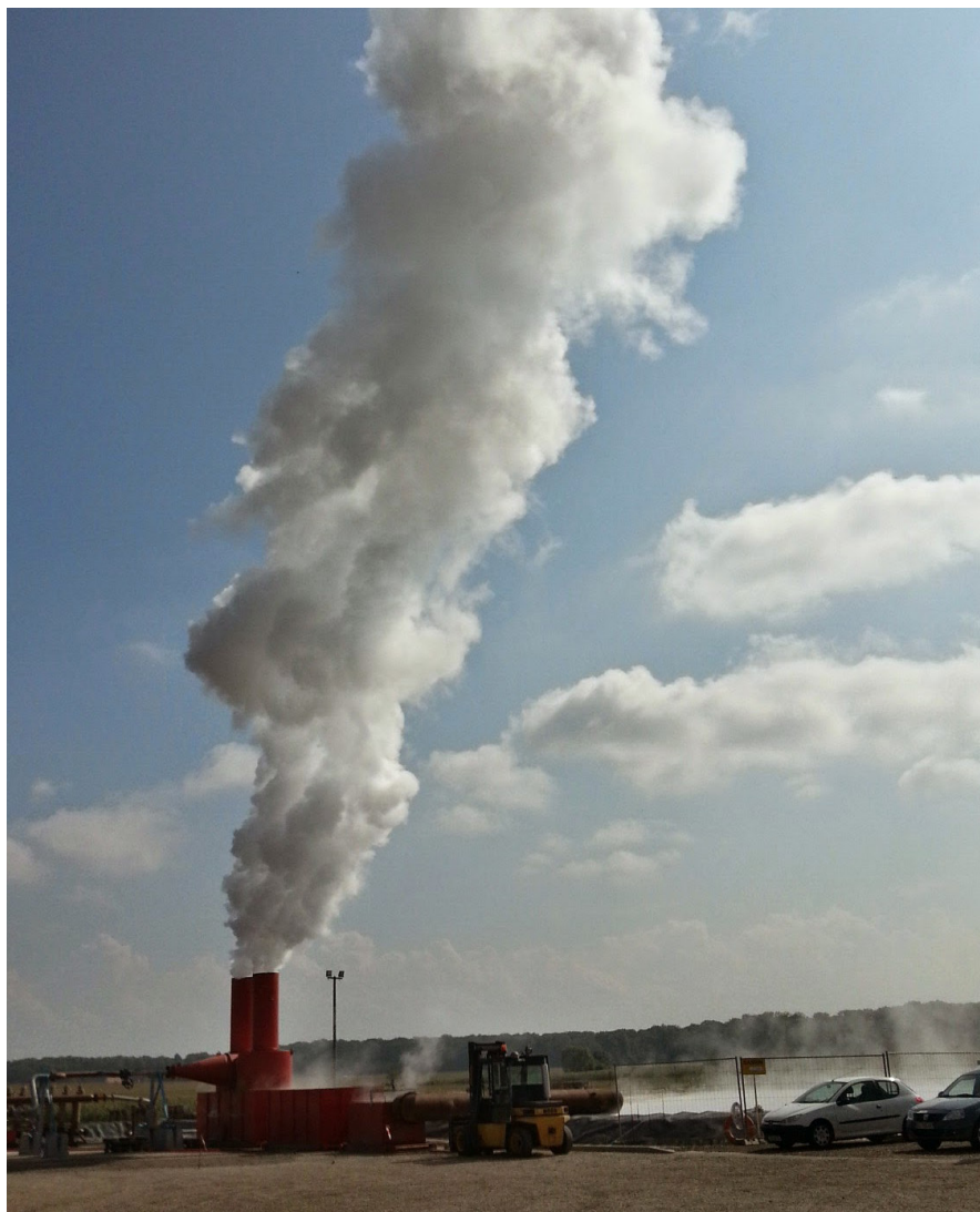
Vrt geotermální elektrárny Rittershoffen ve Francii před dokončením elektrárny. Vrt při hloubce 2,5 km poskytuje teplotu až 160°C. Foto Jan Holeček
