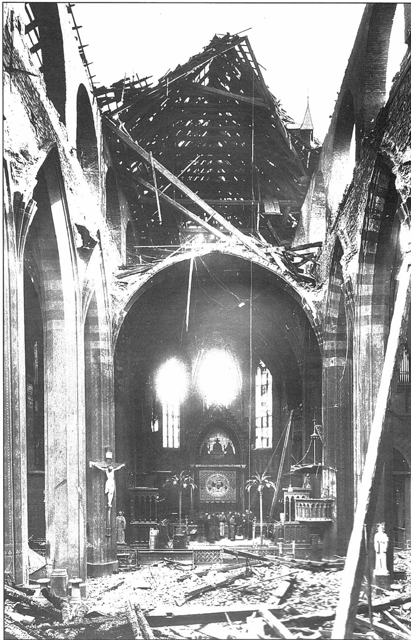
Obr. 4a – Klášter v Emauzích v Praze poškozený po bombardování v únoru 1945 (foto V. Uher)
