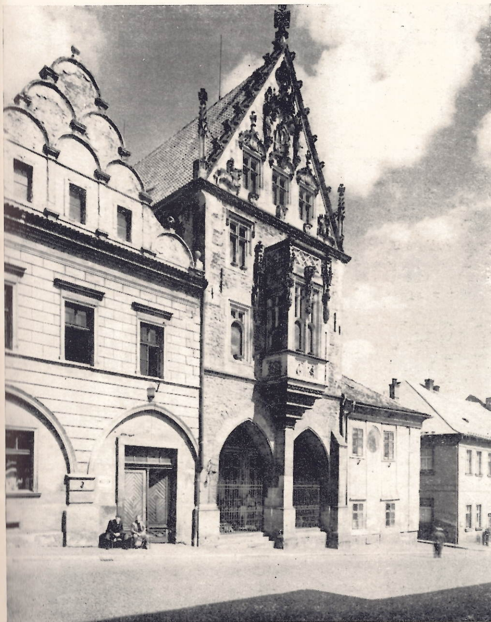
Kutná Hora, Kamenný dům. Typický příklad puristické restaurace. Z existující dokumentace původního stavu lze soudit, že před restaurací byly téměř všechny gotické sochařské a kamenické detaily poměrně dobře dochovány, byl se stopami mechanického poškození. Jak ukazuje snímek dnešního stavu, došlo při restauraci k téměř úplné, fyzickým stavem originálu neodůvodněné výměně původní bobaté kamenické výzdoby, nabízené výtvarně tvrdými kopiemi. Lomové, původně omítané zdivo bylo zbaveno omítek a abistoricky vyspárováno. Foto Soňa Divišová
