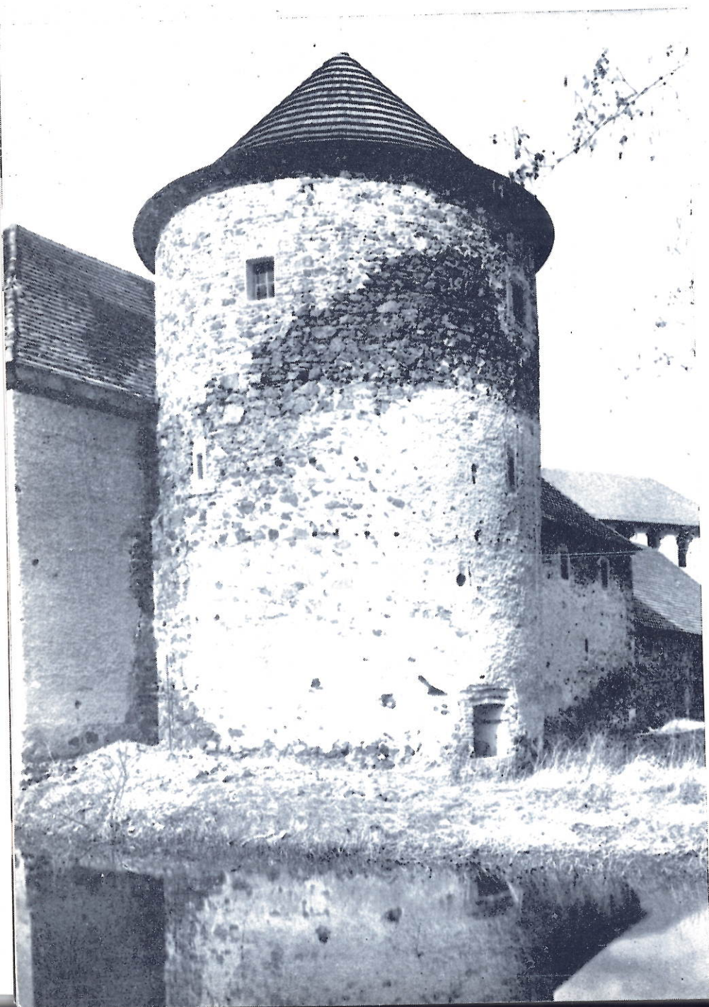
Svibov, státní brad, věž Kašperka. Snímek pořízený těsně po dokončení obnovy v r. 1953 dokládá vysoce kultivovaný, syntetický přístup, typický pro Břetislava Štorma. Dochované originální části věže byly (včetně omítek) pouze citlivě konzervovány, nadezdívky i tradičně převedená střecha zcelily siluetu a nenásilně, avšak při plné rozlišitelnosti, se připojily k originálnímu zdivu. Foto Soňa Divišová
