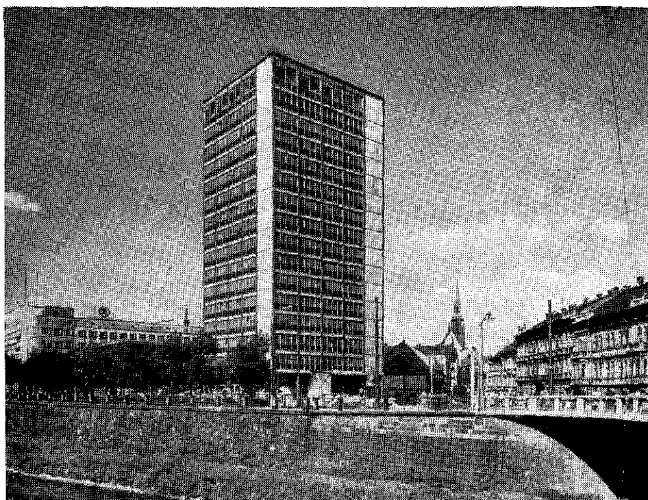
Plzeň — nová administrativní budova ve středu města. Snímek K. Kibic.
