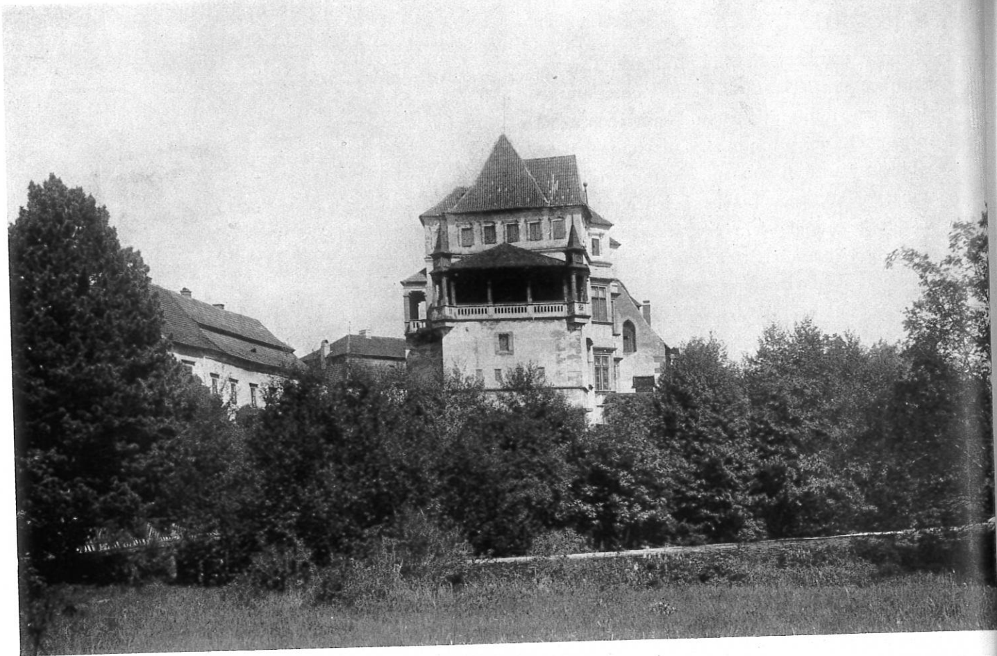
Zámek v Blatné. Pohled na renesanční část z parku. Замок в Блатной — вид из парка на ренессансную часть дворца. Castle in Blatná. View of the Renaissance part of the castle from the park. Château à Blatná. Vue sur la partie Renaissance du parc.
