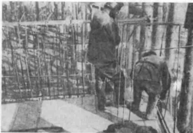
Работа арматурщиков; железо в конструкции примет на себя усилия растяжения, бетон — сжатия
