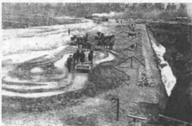
Уплотнение тела дамбы катками. Справа — рейки, поставленные для проверки уклона откоса
