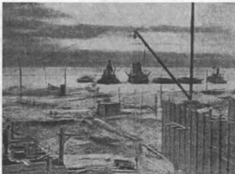
Выемка в земле и сруб из бревен — на такие простые слагаемые разлагал тов. Френкель работу по созданию камеры шлюзов
