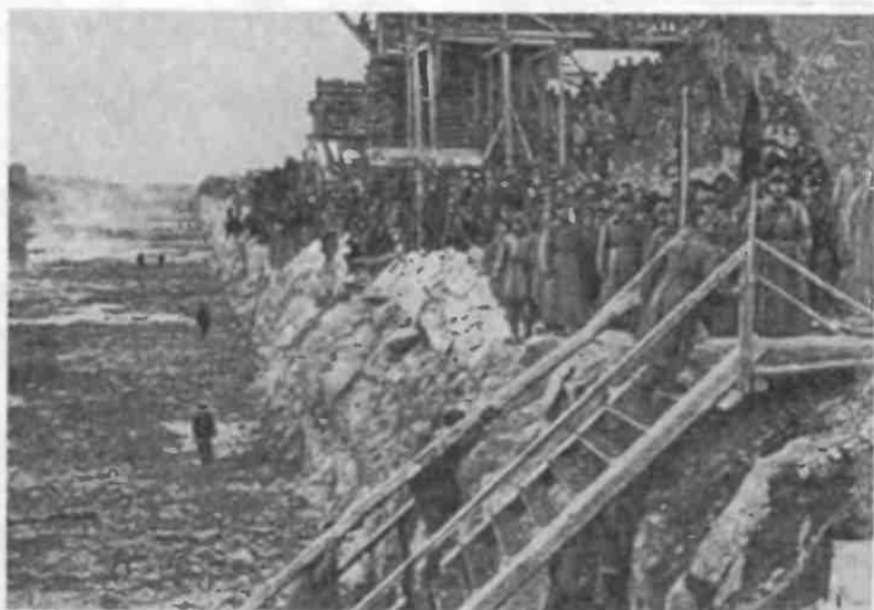
Выемка готова, но зачистка еще не произведена
