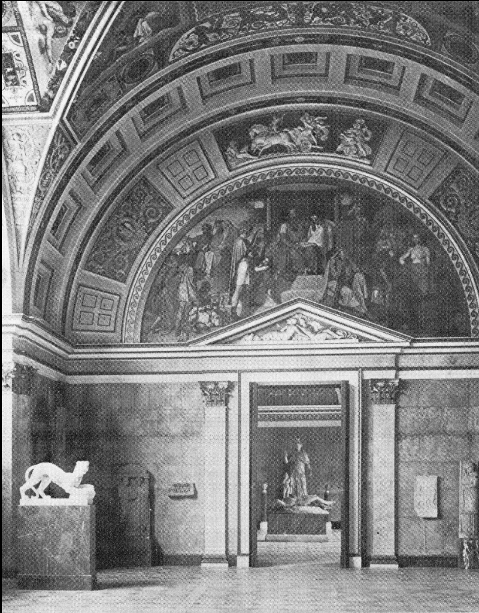
Glyptotéka, sál bohů, stav před zničením
