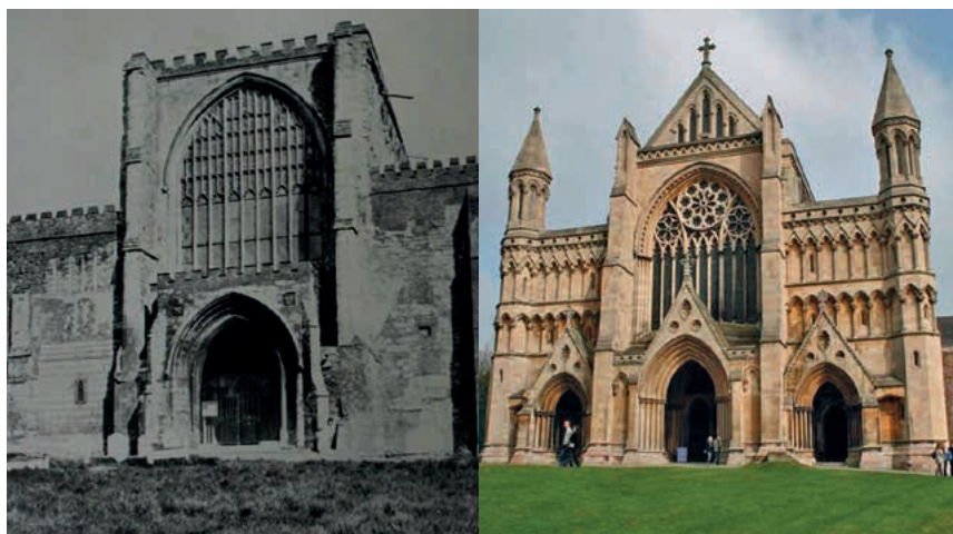
Obr. 13. a 14. Srovnávací fotografie katedrály sv. Albána před a po rekonstrukci (Zdroj: SPAB)
