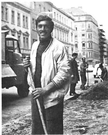
Výkopová parta v Praze na Letné (1972)
