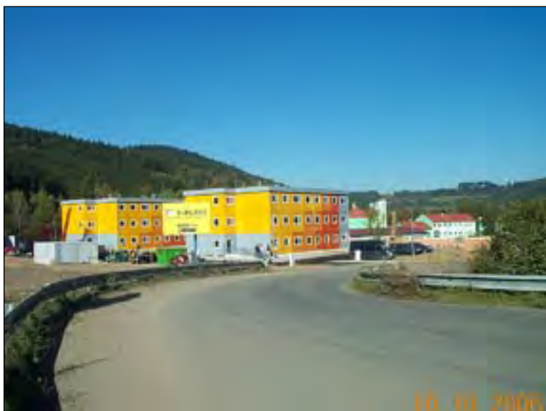
Poschla. Celkový pohled na Poschlu, vlevo v popředí upravená plocha bývalé skládce.
