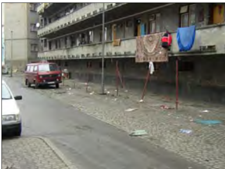
Pavlačový dům č.p. 1336. Parkoviště mezi Pavlačovým domem a poliklinikou.
