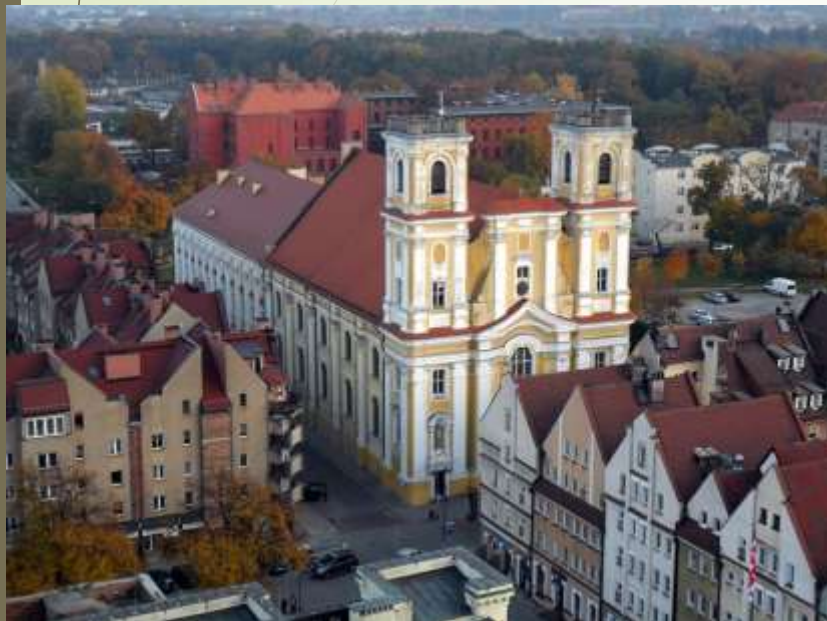
Bývalá kolej jezuitů v Hlohově
