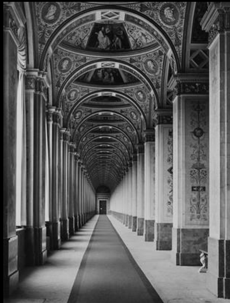
Loggie v horním podlaží jižní strany Alte Pinakothek před zničením
