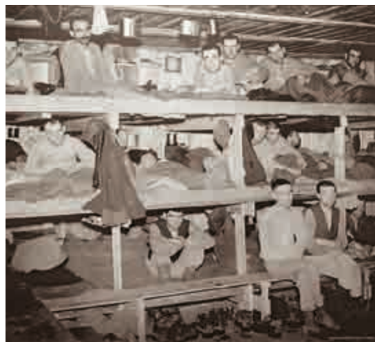
Nasazení přespávali v pracovních táborech, kde byly postavené dřevěné baráky s palandami. V arktické zimě byly vytápěny malými kamny. Na fotografii jsou sovětští váleční zajatci nasazení v severním Norsku na stavbu železnice.
