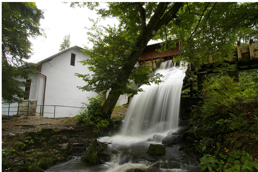
Vodní přepad z vantroků u budovy Kašperskohorské městské elektrárny, foto autor.
