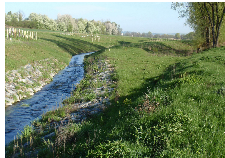
Obr. 3 Horní přechodový úsek mezi původním a revitalizovaným korytem. Foto Radim Jarošek
