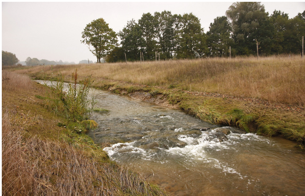
Obr. 5 Eroze břehu vlivem zvýšeného průtoku. Foto Radim Jarošek
