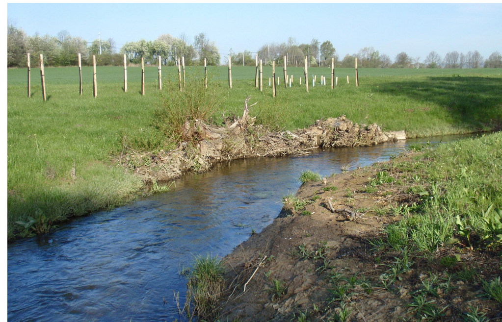
Obr. 7 Pomístně byly do nárazových částí břehů umístěny kořenové trsy. Foto Radim Jarošek
