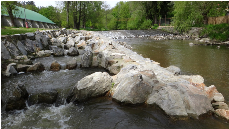
Obr. 3. Střední část rybího přechodu na Blanici ve vlašimském parku u kamenného mostu (lokalita 3).
