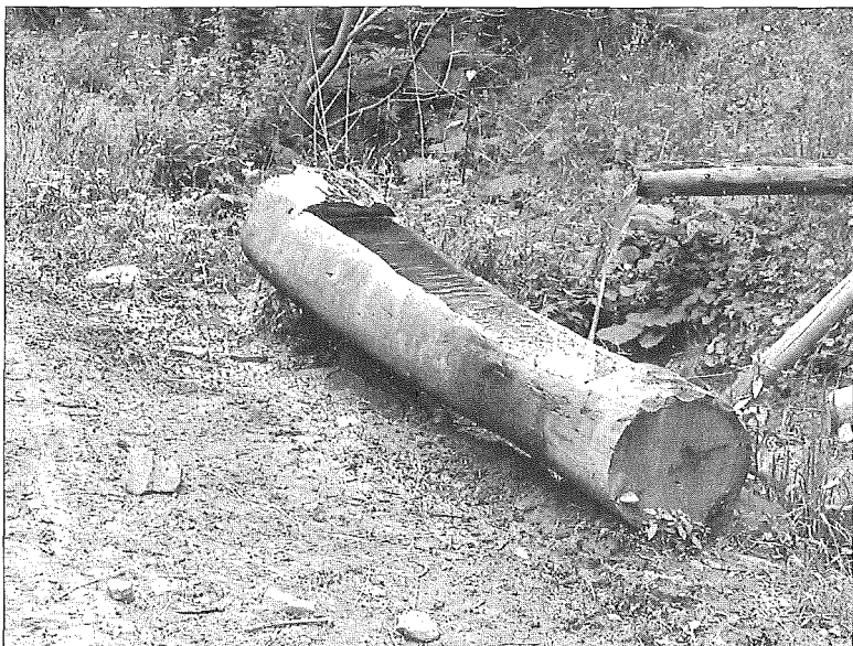
Jednoduchý rezervoár na jímání vody ze slabých a nepravidelně vodnatých pramenů. Osturňa, okr. Poprad, Zamaguři, šedesátá léta 20. století, foto autor
