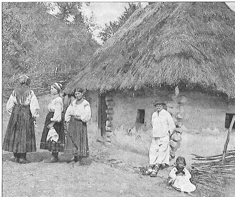
Dvouprostorový srub „v kožichu“ s valbovou střešou krytou došky – Poroškovo na Podkarpatské Rusi; neznámý fotograf, dvacátá až třicátá léta 20. století
