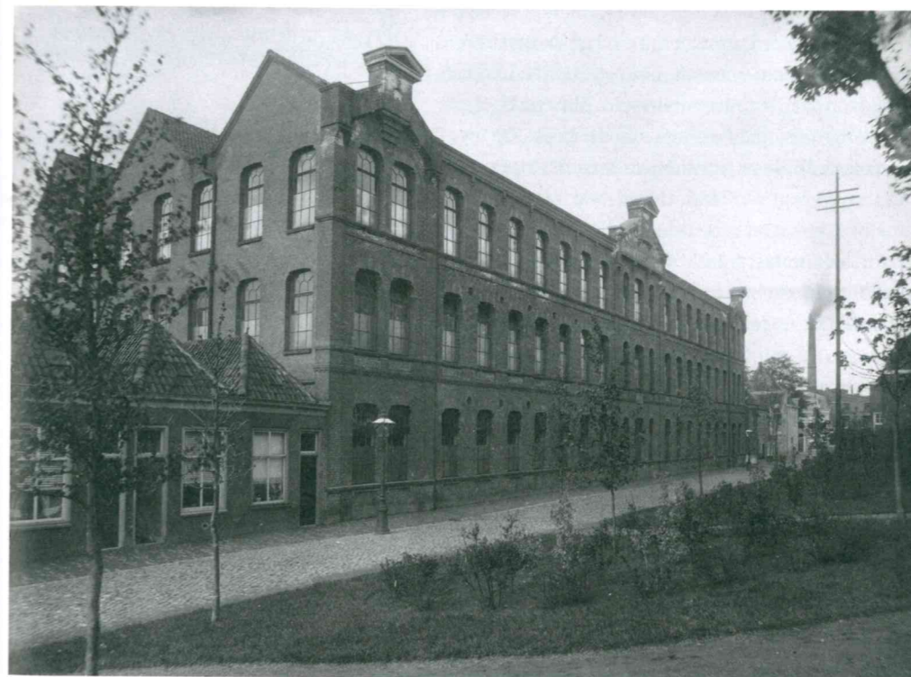
Een van de fabrieken van Clos & Leembruggen, producent van sajete en breiwool, ca. 1900. Deze fabriek werd gebouwd op de plaats waar eerder de spinnerij van Van Heukelom stond. Daar werd in 1816 de eerste stoommachine in de (Noord-)Nederlandse textielnijverheid geplaatst (RAL).
