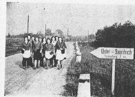
[DER BAU DES SÜDOSTWALLS IN DER UNTERSTEIERMARK] (1944/45)
