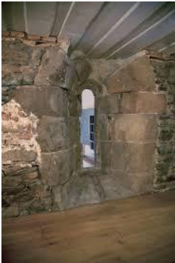
Hospodářský dvůr v areálu kláštera, románské okno
