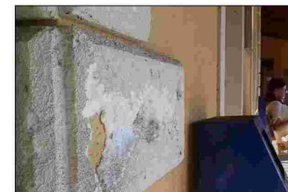
polystyrenová bosáž, dopravní ter- minál Telč
