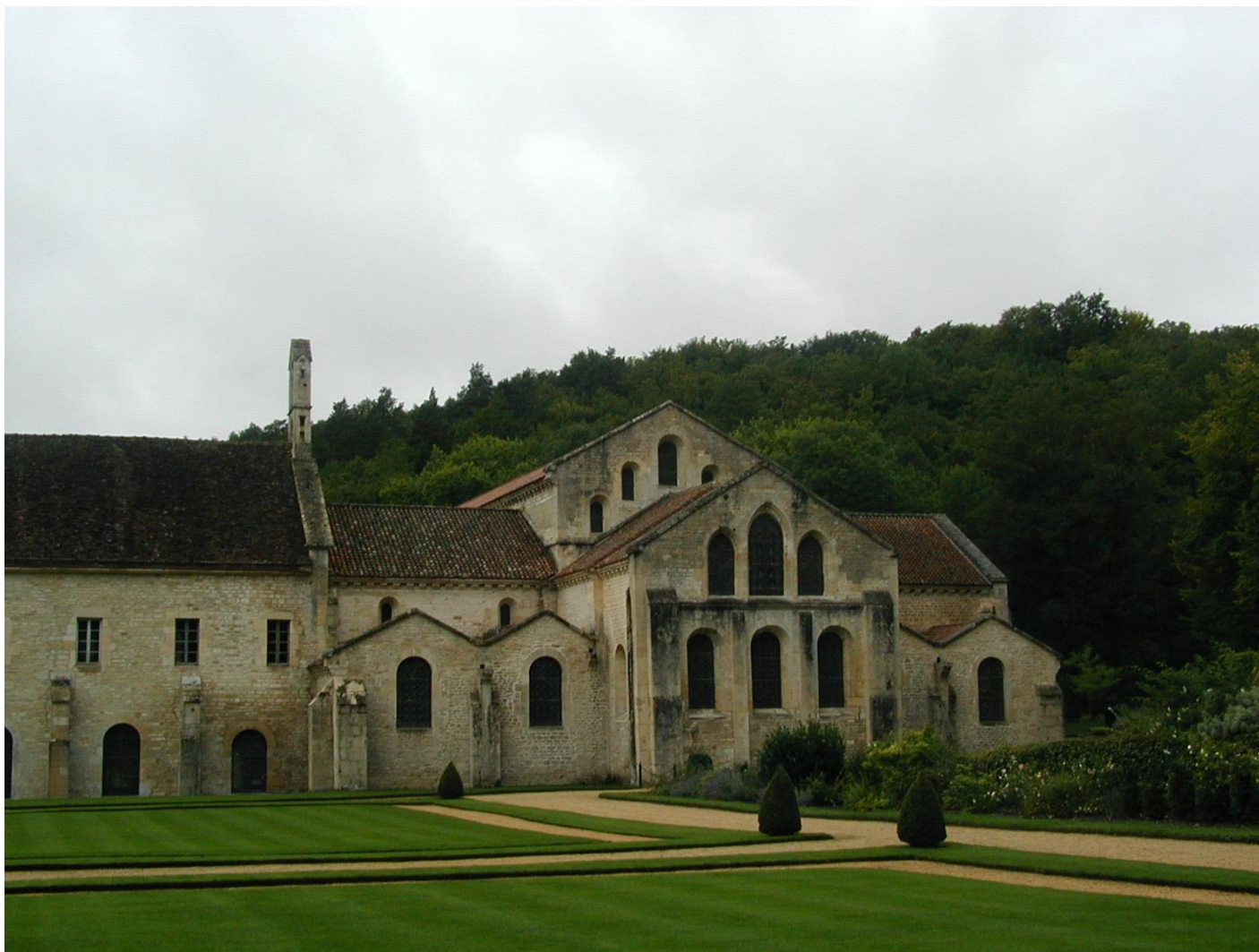
Fontenay, pohled ze zahrady na východní křídlo
