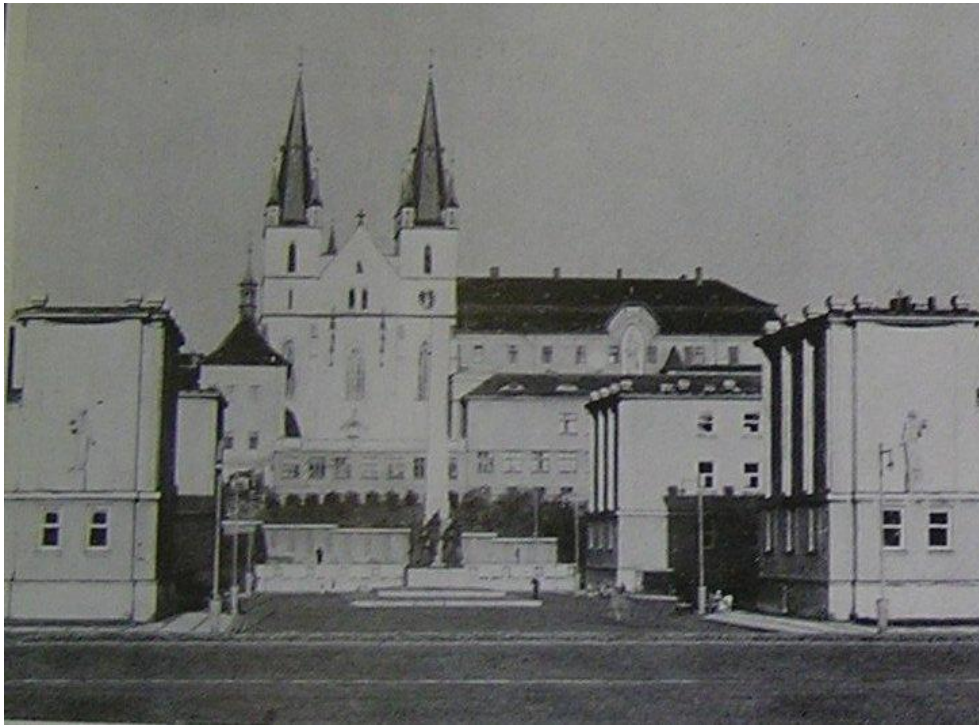
Obr.34: Klášter Na Slovanech, Praha, novogotická přestavba z konce 19. století
