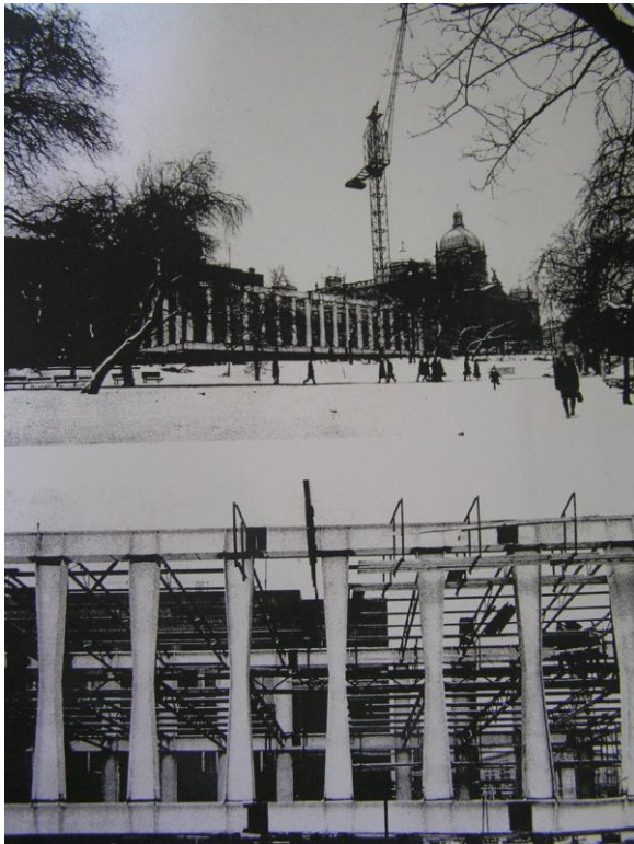
Obr.52: Karel Prager: budova Federálního shromáždění, Praha 1966-1974, fotografie z průběhu stavby s detailem Vierendeelova nosníku
