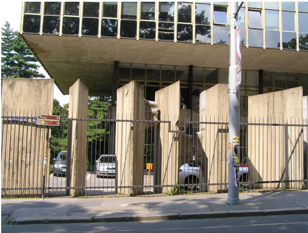
Obr.40: Miloslav Chlupáč: průchozí betonová stěna, Praha, současný stav
