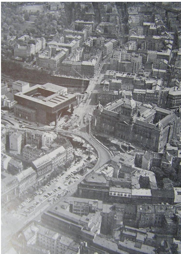
Obr.41: Karel Prager: budova Federálního shromáždění, Praha, 1966-1974, budova v kontextu s okolím
