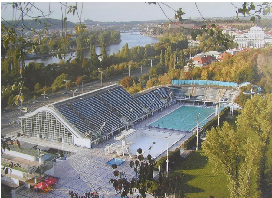
Obr.1: Richard Podzemný: Plavecký stadion v Praze Podolí, 1960-1965, celkový pohled na současný stav
