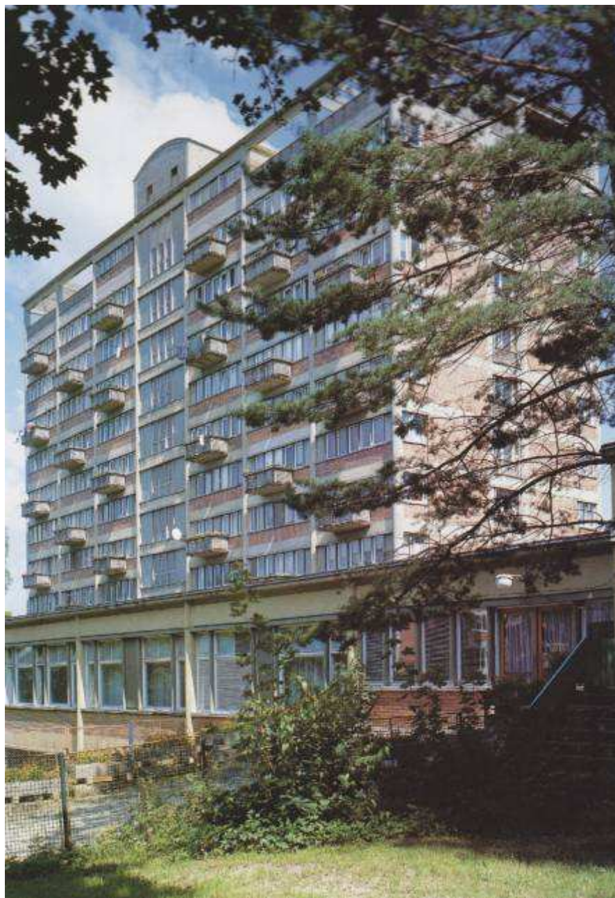
Jiří Voženílek, kolektivní dům ve Zlíně, 1948-50
