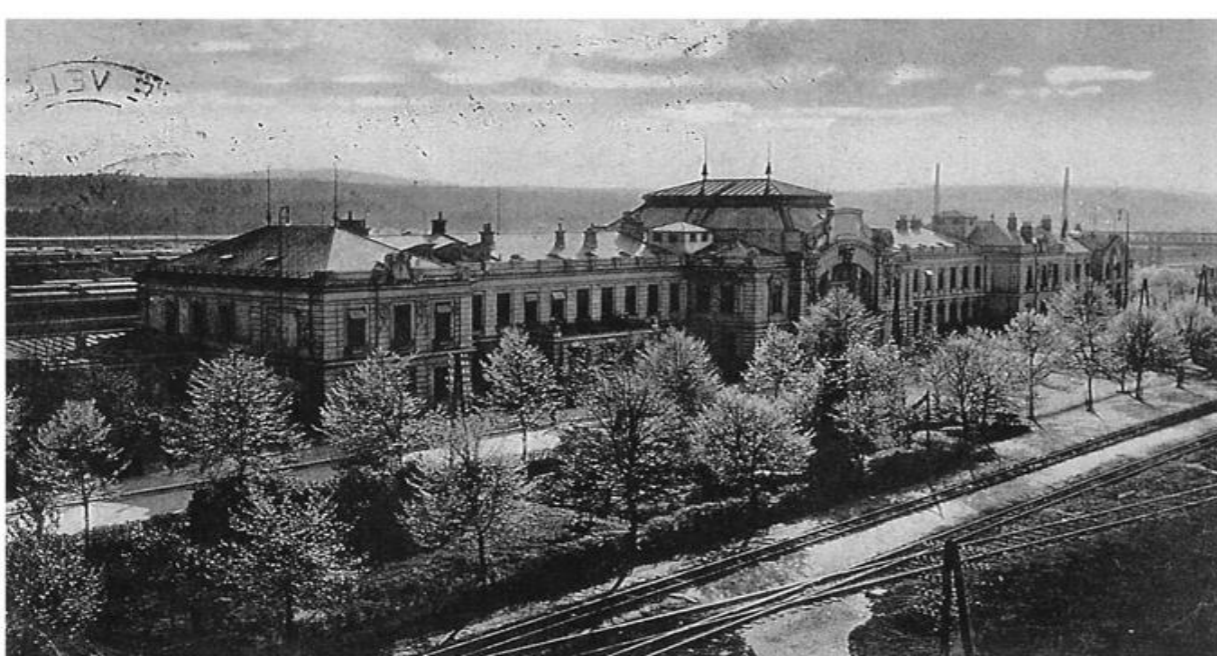
nahledový pohled na budovu nádraží
